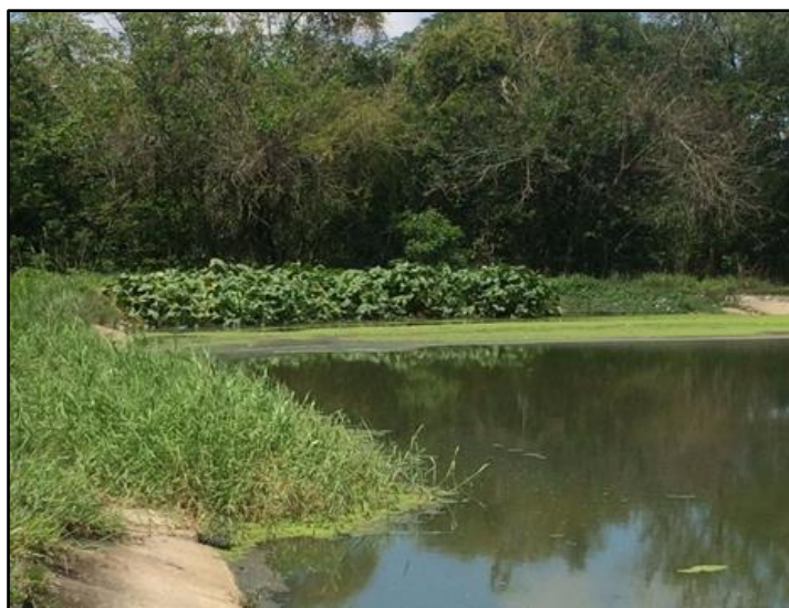
Figura 4. Crescimento de vegetação na lagoa facultativa da ETE de Canas (SP).
